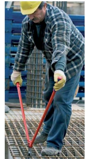
Die besondere Kopfform des Mattenschneiders 71 82 950 ermöglicht das Schneiden flachliegender Baustähle
